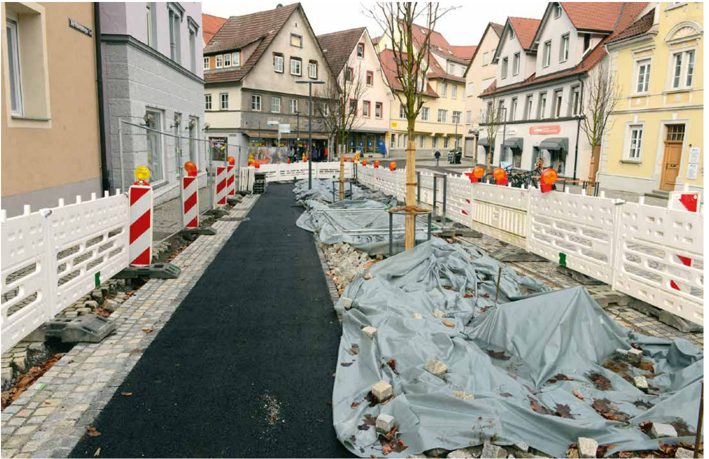
Das Foto zeigt die noch am Ravensburger-Tor-Platz ausstehenden Restbaumaßnahmen. Im Wesentlichen müssen noch Pflasterarbeiten sowie der Einbau der geplanten Radabstellbügel erfolgen. Der Schwarzasphalt im Mobilitätsband stellt nur ein Provisorium dar. Er soll im Laufe des Sommers durch Farbasphalt, wie er bereits in Teilen der Altstadt verbaut worden ist, ersetzt werden. (j.b.)
